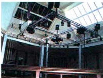
в камерном зале – систему Trumpf 95 (длина 10 м; ручной привод). Рельсовые "дороги" Gerriets можно использовать и для перемещения тяжелых грузов – они выдерживают распределенную нагрузку 200 кг/м при креплении рельсовых модулей в точках с шагом 2 метра.
